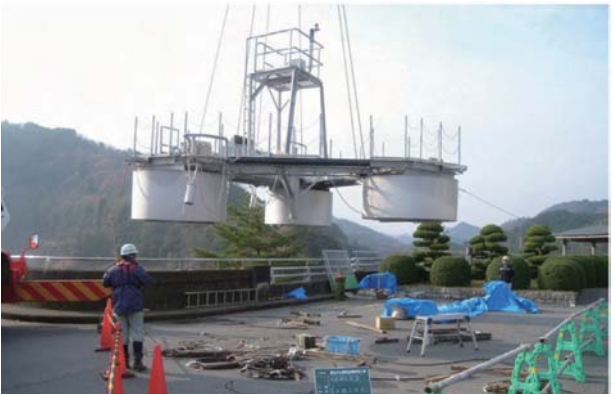
浅層曝気循環設備の設置(室生ダム)
