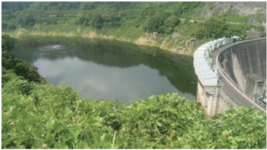
高山ダム貯水池状況
