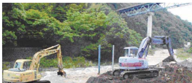
土砂の攪拌・投入状況
